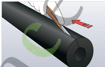
Используйте острый нож. Держите нож под небольшим углом к трубке, разрезая ее вдоль
