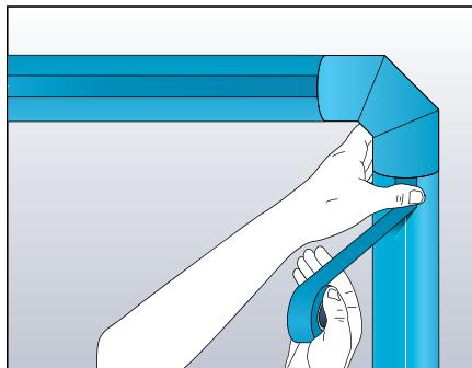
Для обеспечения дополнительной безопасности швов необходимо проклеить соединения самоклеящейся лентой Armaflex Rail SD. Убедитесь, что поверхность изоляции сухая и чистая. Для очистки изоляции от пыли и других загрязнений используйте очиститель Armaflex.
