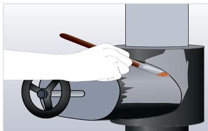
**Armafinish 99** - защитная краска на водной основе. Для защиты от УФ-излучения необходимо нанести 2 слоя краски. Первый слой может быть нанесен сразу же после монтажа теплоизоляции. Второй слой должен быть нанесен не позднее 7 дней после нанесения первого.
