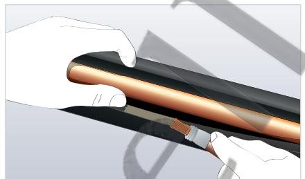
1. Разрежьте изоляционную трубку вдоль по всей длине при помощи острого ножа (по плоской стороне)\*.
